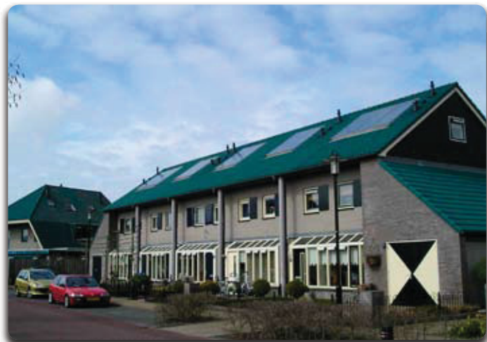
WWF-woningen met PV-panelen aan Wikke te Nijkerk
