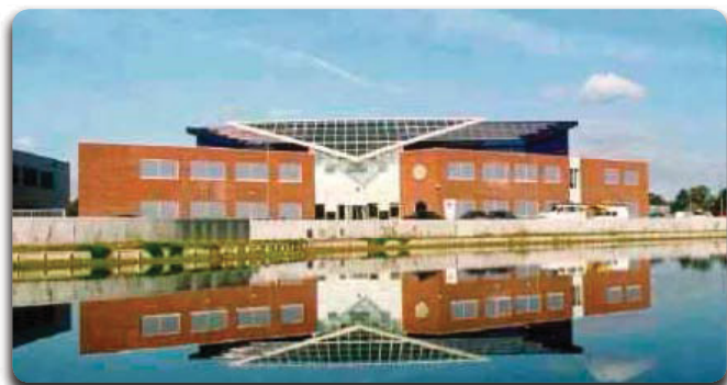
PV-panelen in het dak van een kantoor
